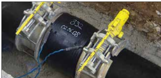
3.39 Rundungsschellen für E-Muffen (Bildquelle: +GF+)
