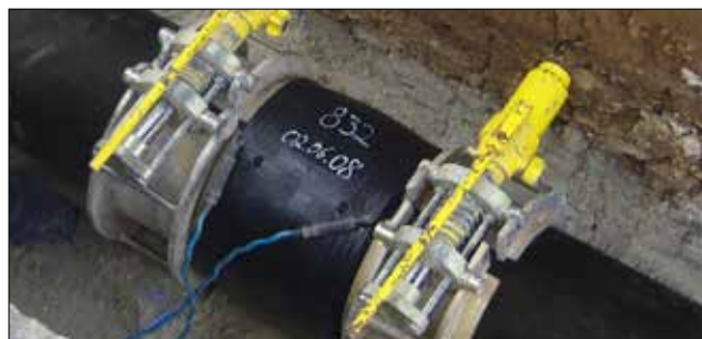
7.38 Rundungsschellen für E-Muffen (Bildquelle: +GF+)
