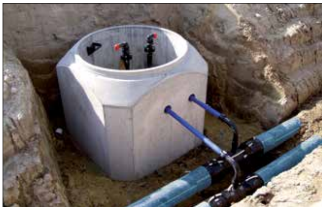
4.56 Anbohrarmaturen zur Schachtanbindung
