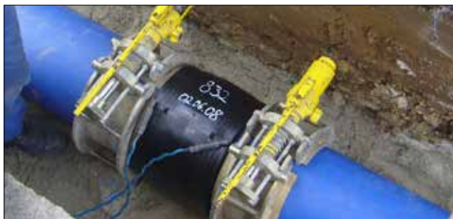
4.57 Rundungsschellen für E-Muffen (Bildquelle: +GF+)
