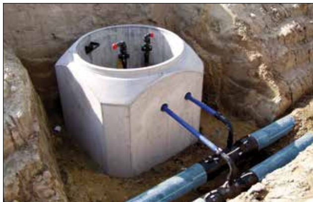
6.80 Anbohrarmaturen zur Schachtanbindung
