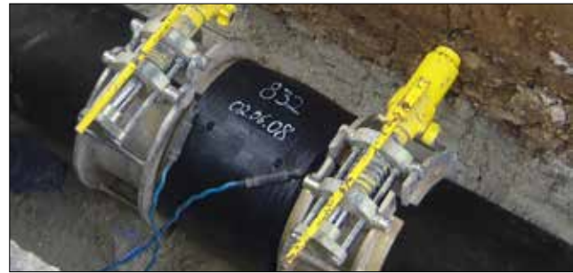
8.49 Rundungsschellen für E-Muffen (Bildquelle: +GF+)
